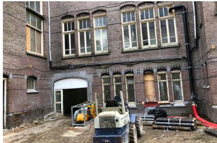
Eenvoudige entree vóór renovatie
