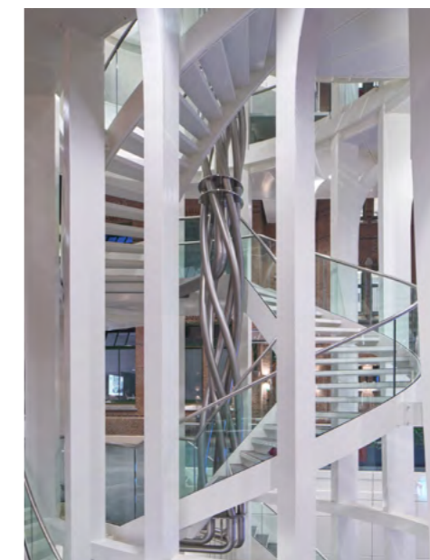
Hoofdramp met hemelwaterafvoerbuizen
