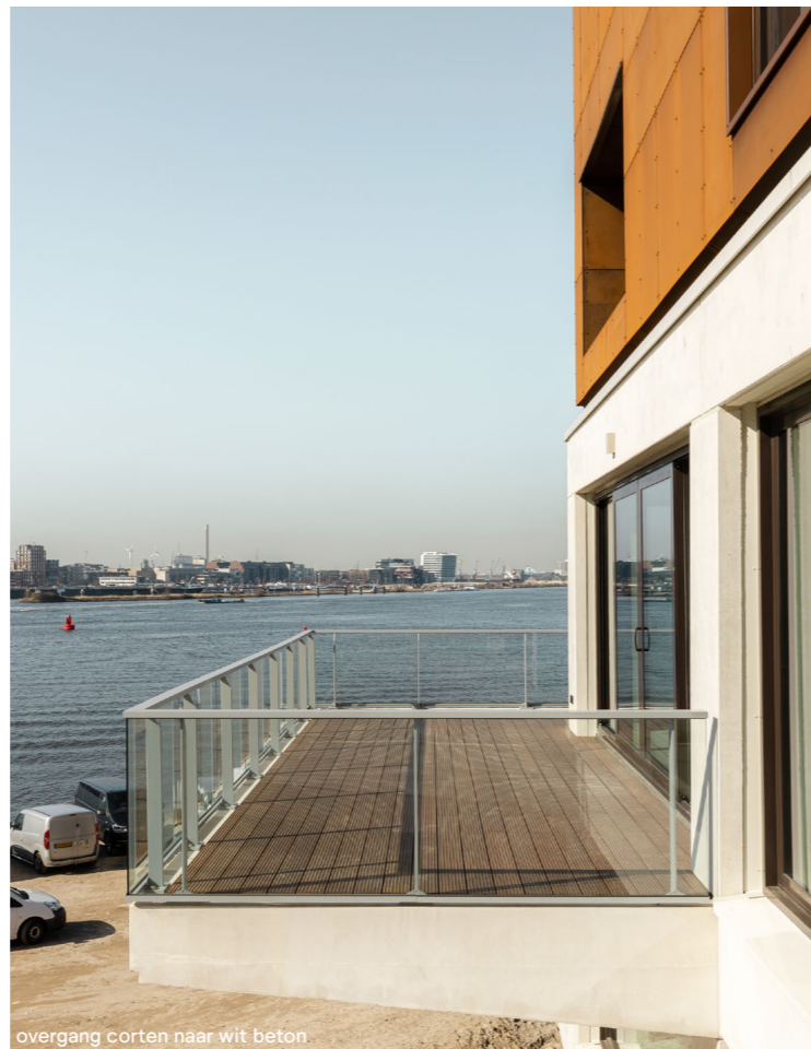
overgang corten naar wit beton
