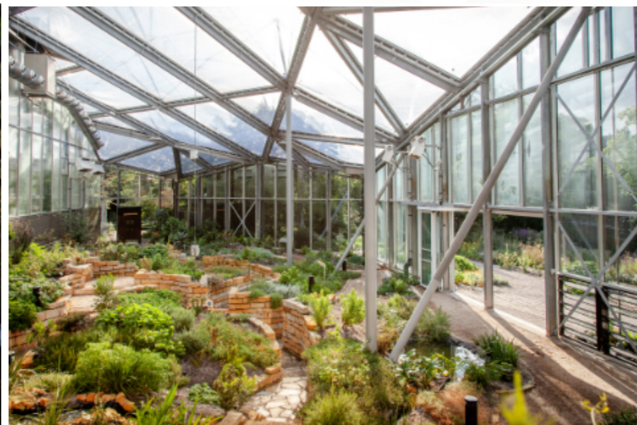
Vernieuwde Kaapse kas met open te zetten schuifdeuren, temperatuurgevoelige automatische dakluiken en gevellamellen
