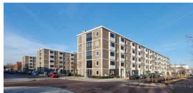
van de 6 oorspronkelijke flats zijn er 3 behouden
