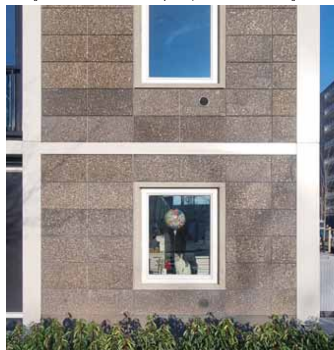
de hergebruikte betonnen kaders omlijsten opnieuw het leven in het gebouw
