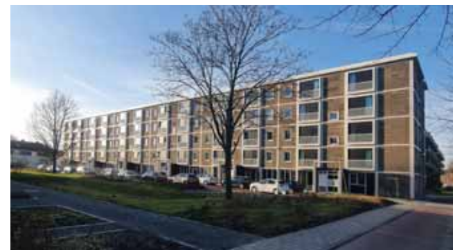
de tuinen tussen de gebouwen, met speeltoestellen van Aldo van Eijck, zijn hersteld en rainproof gemaakt
