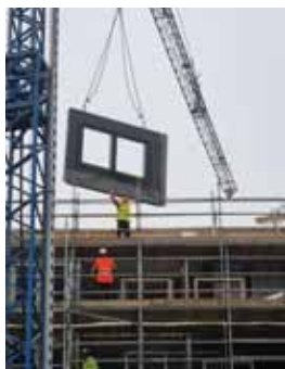
het bestaande casco wordt ingepakt met houtskeletbouw geveldelen
