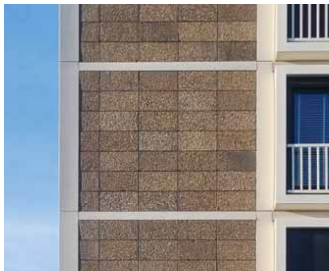
De verkleuring van de tegels is bepaald door hun vorige 'positie' in het gevelvlak. Een 'random' terugplaatsing in de gevel levert een maximaal levendig patroon op, dat recht doet aan de 60-jarige geschiedenis van de gebouwen
