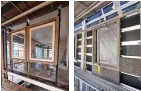
betondelen in oorspronkelijke, ongeïsoleerde situatie (links) en teruggeplaatst op houtskeletbouw voorzetgevel (rechts)
