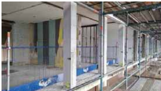
het gebouw is eerst teruggebracht tot het casco
