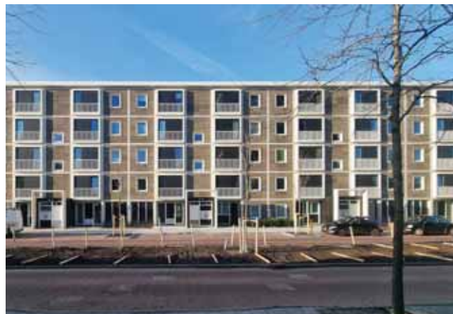
De verkleuring van de tegels is bepaald door hun vorige 'positie' in het gevelvlak. Een 'random' terugplaatsing in de gevel levert een maximaal levendig patroon op, dat recht doet aan de 60-jarige geschiedenis van de gebouwen
