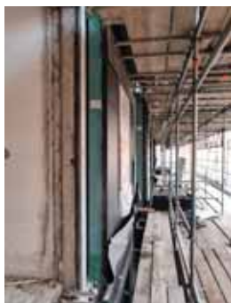
het bestaande casco wordt ingepakt met houtskeletbouw geveldelen
