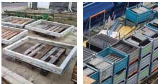
depot op de bouwplaats van her te gebruiken betondelen
