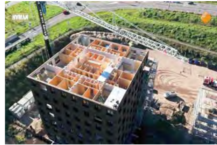
Opname constructie omroep HUMAN - NPO
