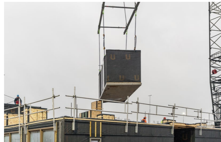
het inhijzen van de modules
