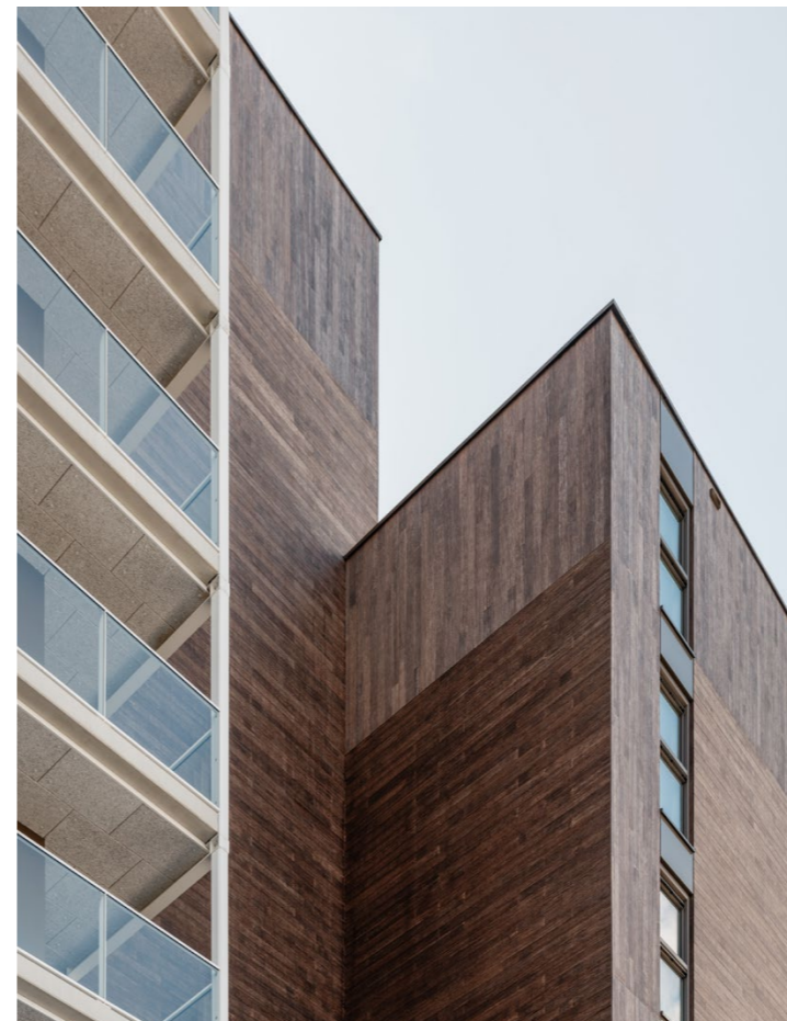
de bamboe gevel
