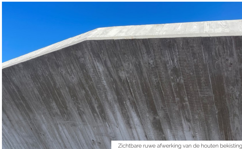
Storten van het beton
