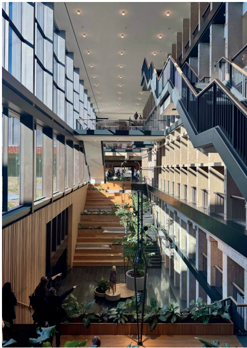
De rastervormige betonstructuur van de voormalige gevel vormt een open binnenwand aan het nieuwe atrium
