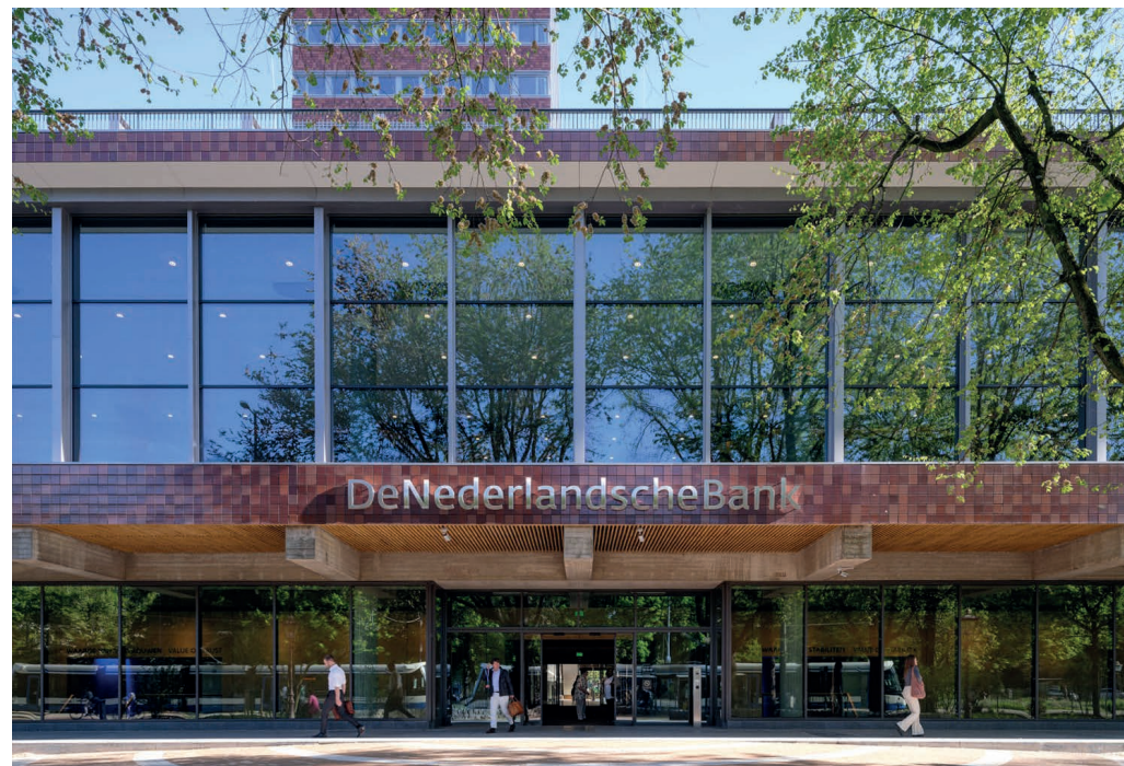
De hoofdingang is verplaatst naar een zijde zonder directe burens en is dwars door de voormalige goudkluis heen gezaagd
