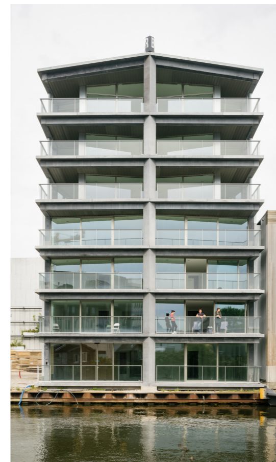
De architectuur sluit aan op de industriële sfeer en nautische geschiedenis van het gebied. De basis is een krachtige gestapelde betonstructuur. De open hoeken en de kapvorm accentueren de bijzondere locatie van het gebouw. Het dak knikt in twee richtingen en de middenkolommen zijn gedraaid in lijn met de knik in het kanaal.
