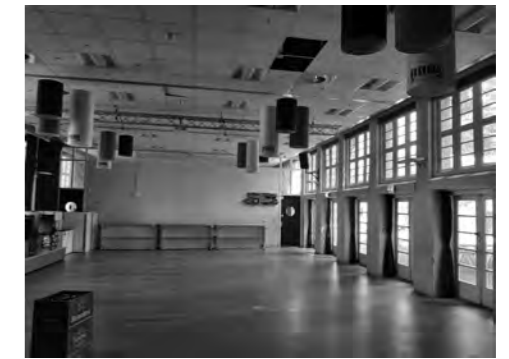
Het houten plafond uit de gymzaal is hergebruikt als akoestisch plafond
