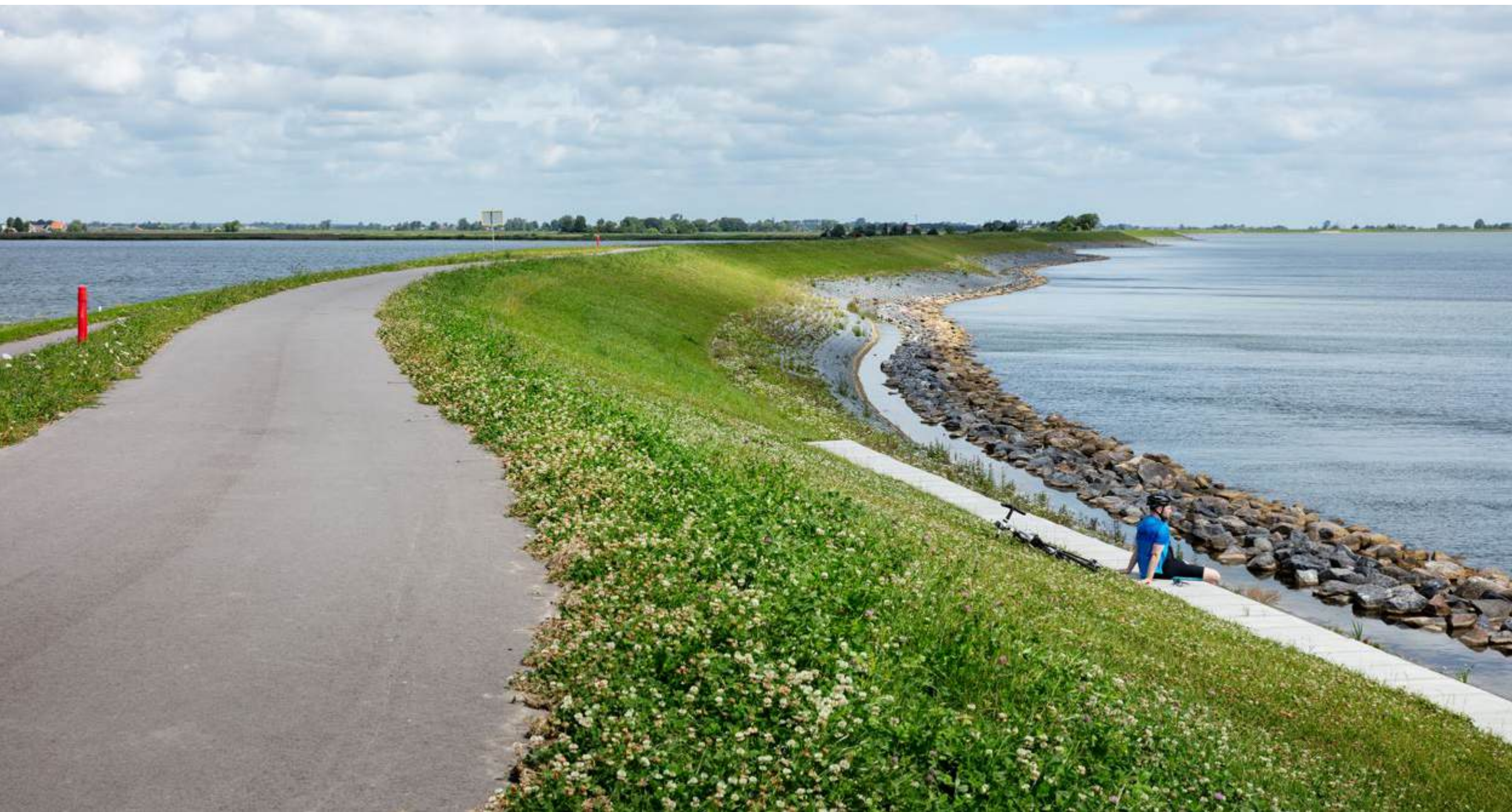
Versterking Markermeerdijken / bruggen stadsstrand Hoorn - Provincie Noord-Holland
