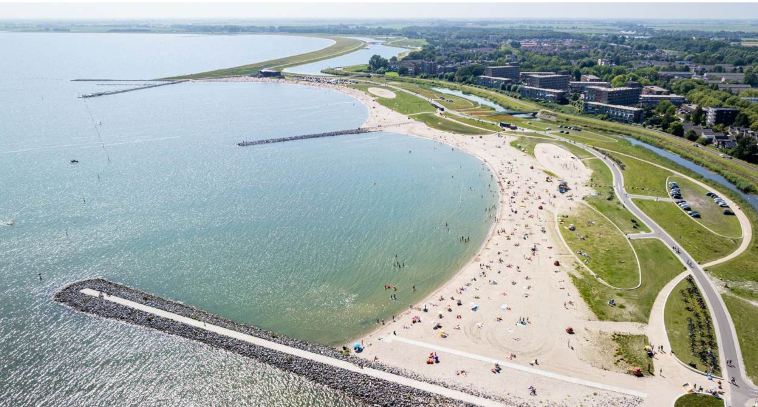
Versterking Markermeerdijken / bruggen stadsstrand Hoorn - Provincie Noord-Holland
