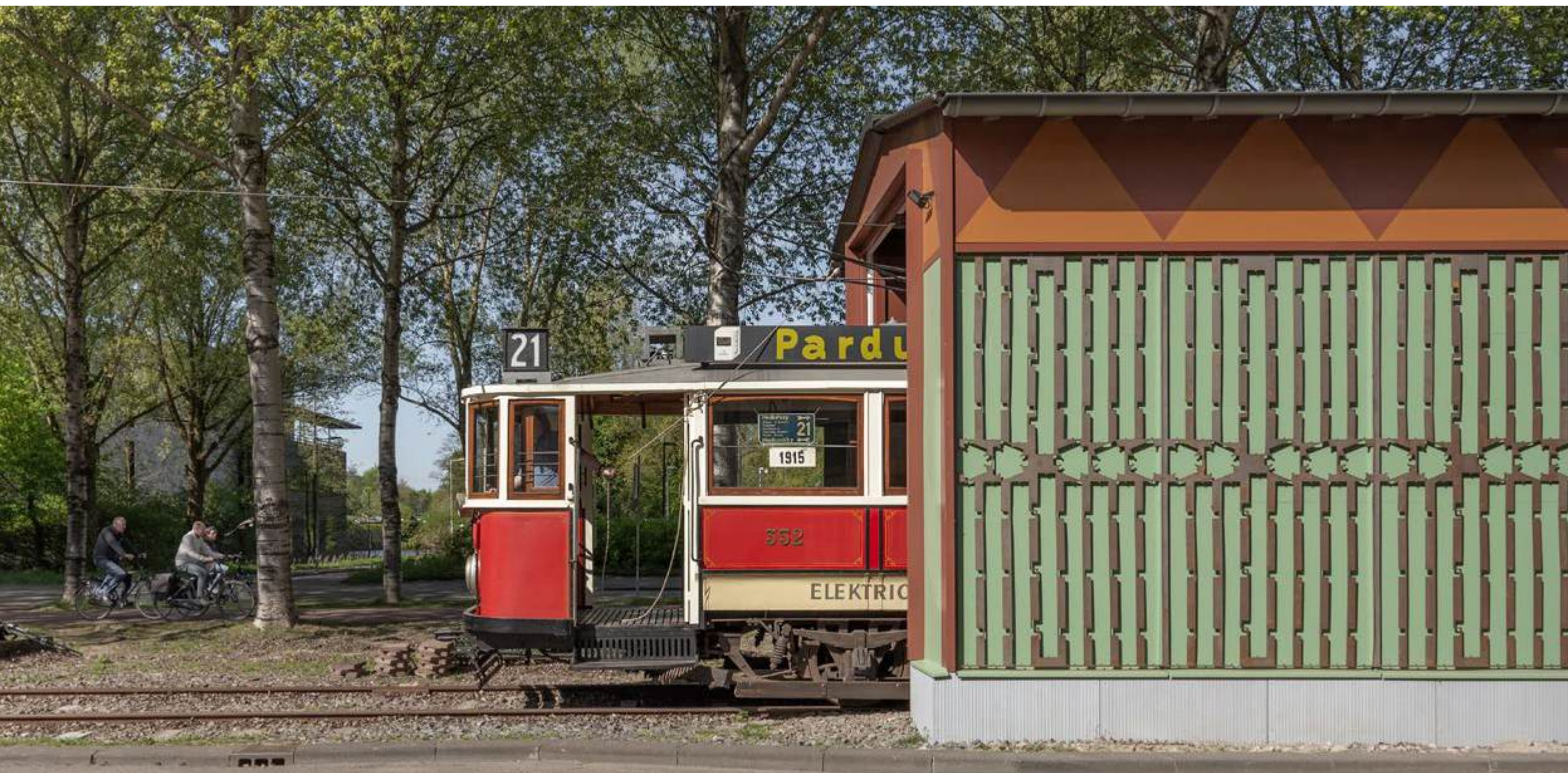
Tijdelijke Tramremise - Amsterdam
