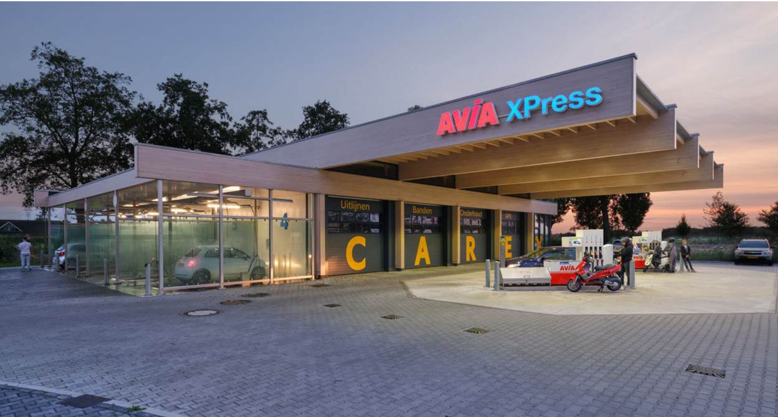
Servicestation Verzetslaan - Purmerend
