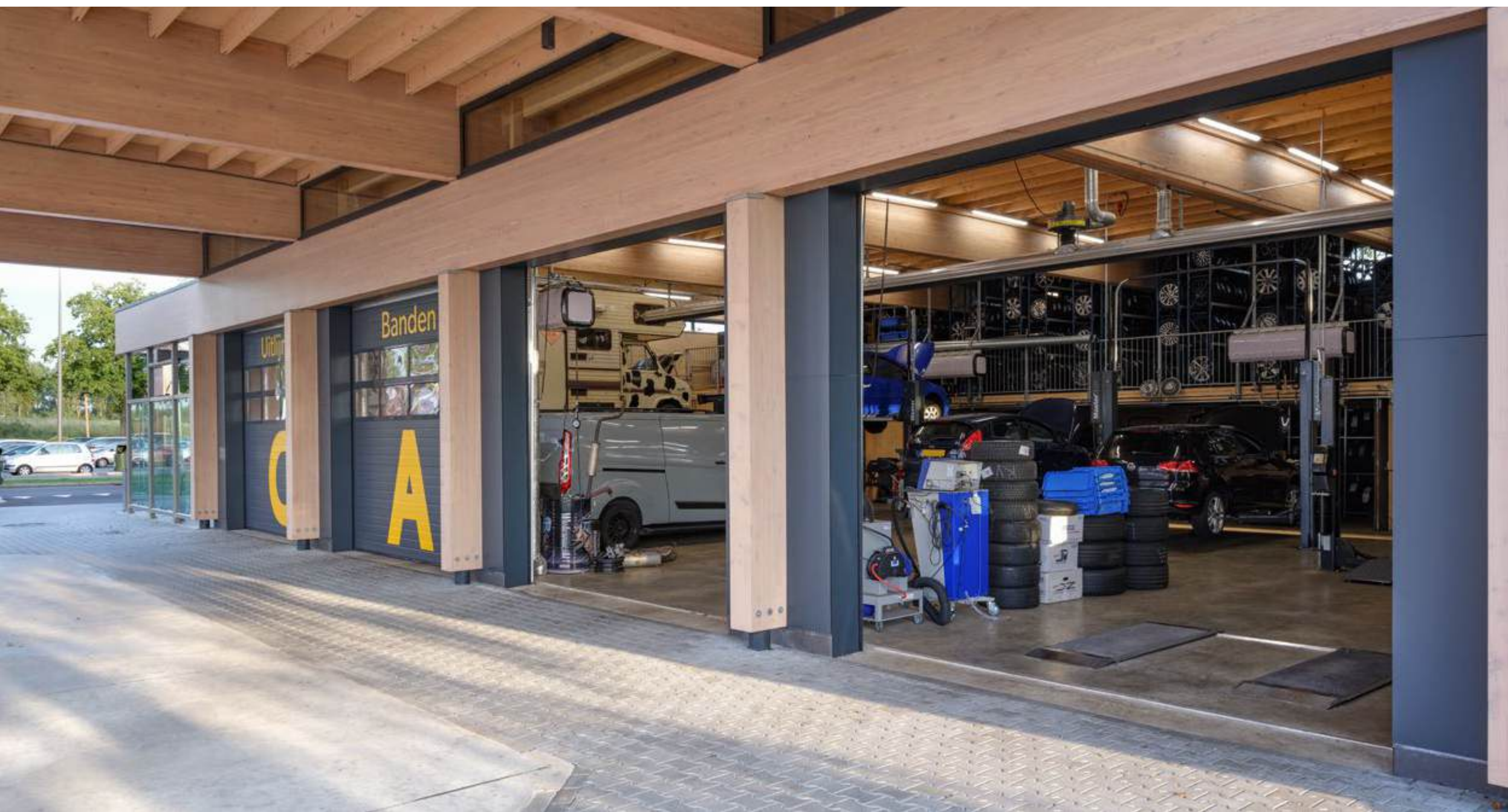
Servicestation Verzetslaan - Purmerend
