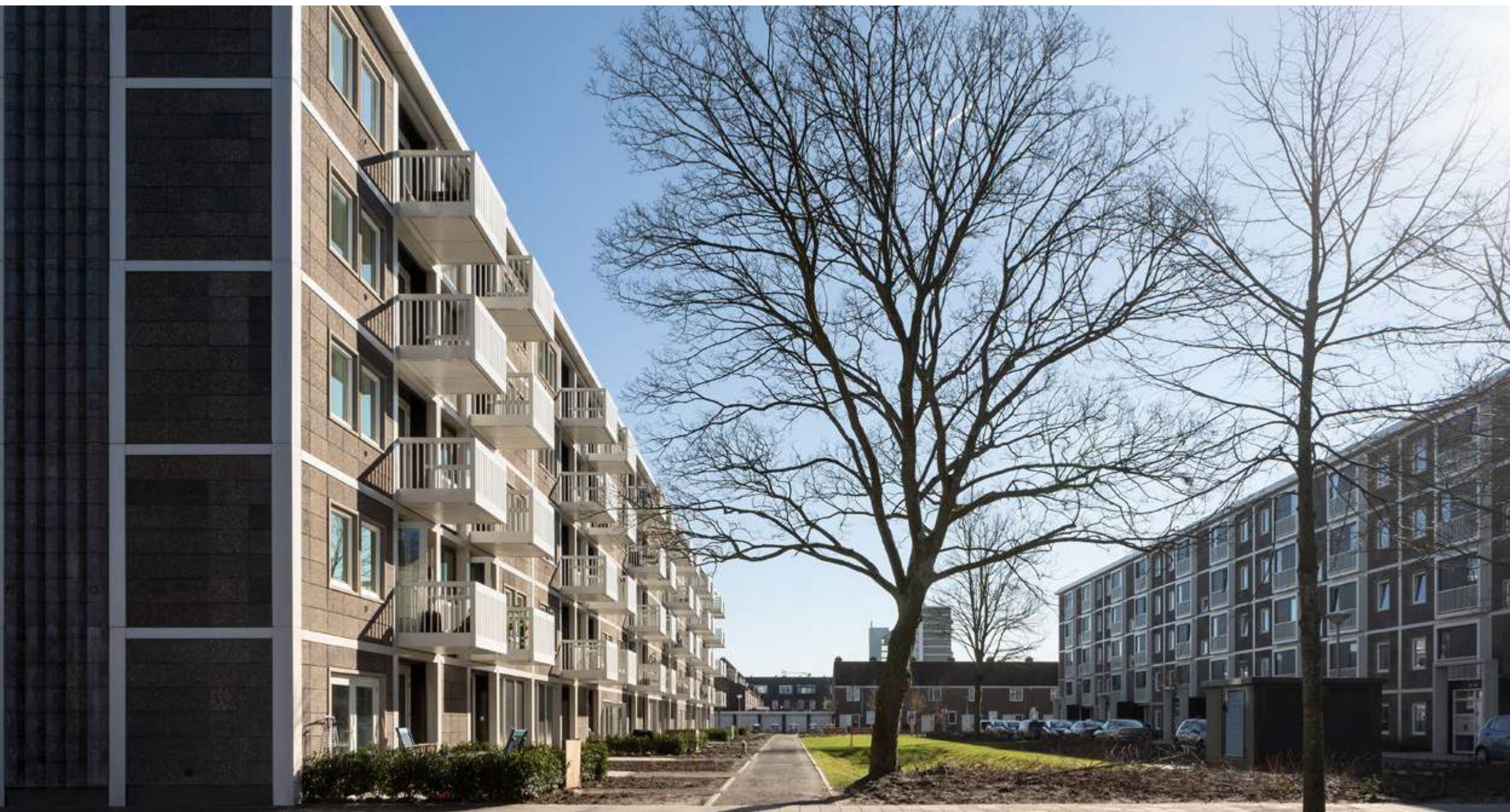
Circulaire gerenoveerde portieketageflats - Amsterdam-Osdorp
