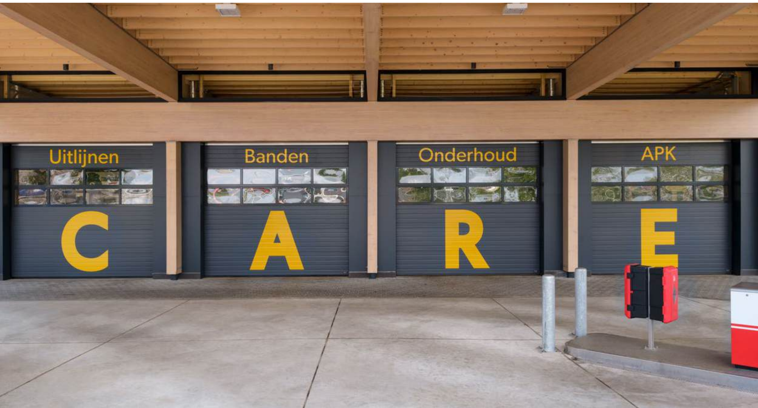
Servicestation Verzetslaan - Purmerend
