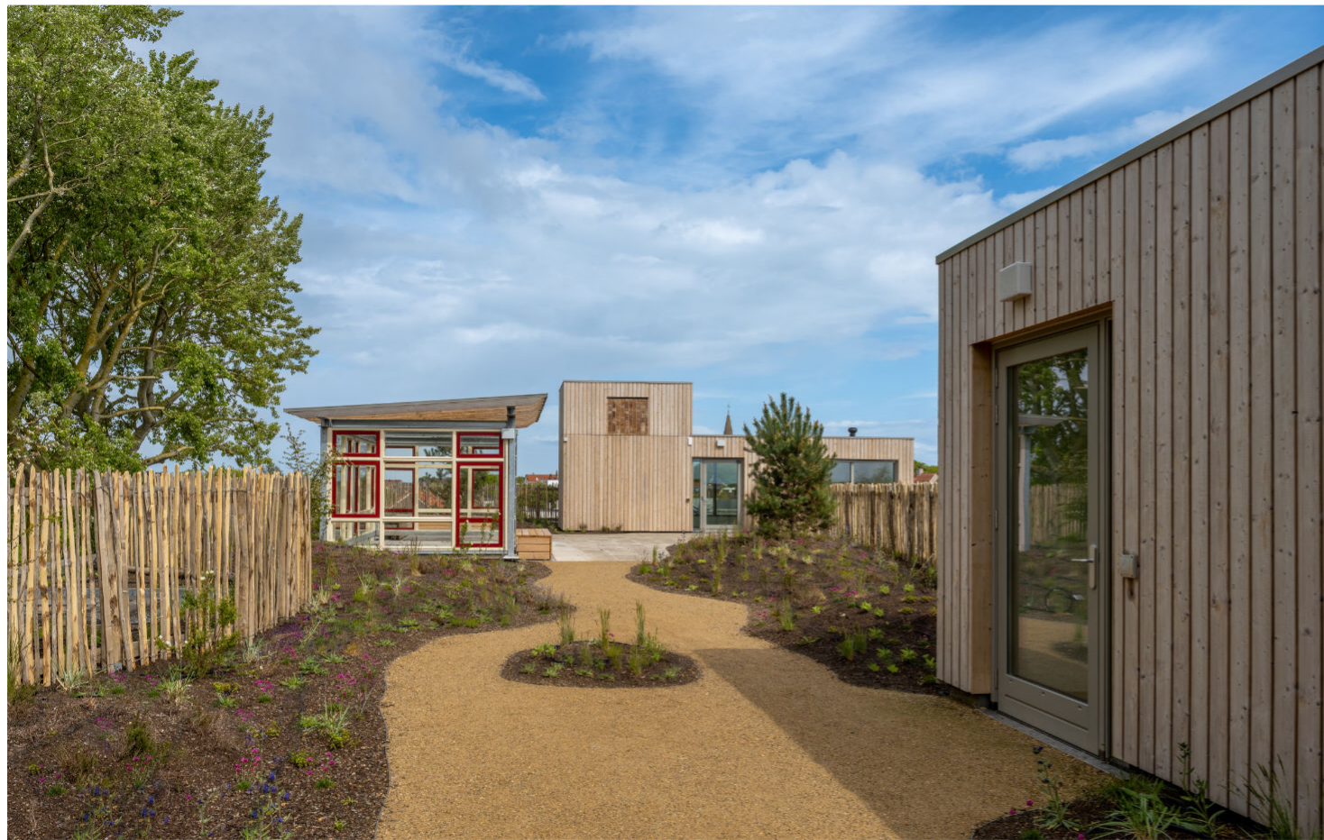
Texels duindak in aanleg
