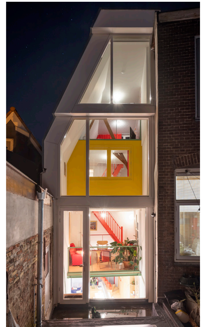
foto: avondbeeld van de achtergevel 'op de vlucht', zichtbaar zijn ook de nieuwe rode trappen en originele spanten
