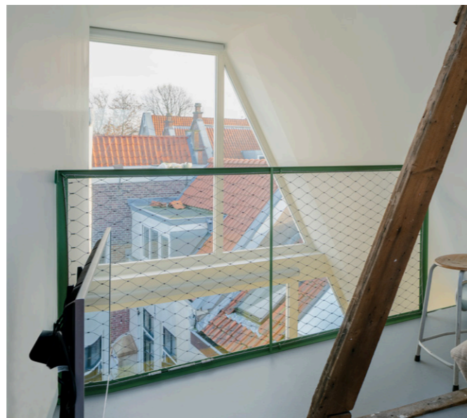
foto's (van boven naar beneden): 't kraaiennest met spant en uitzicht over het daklandschap straatgevel met nieuwe kap
