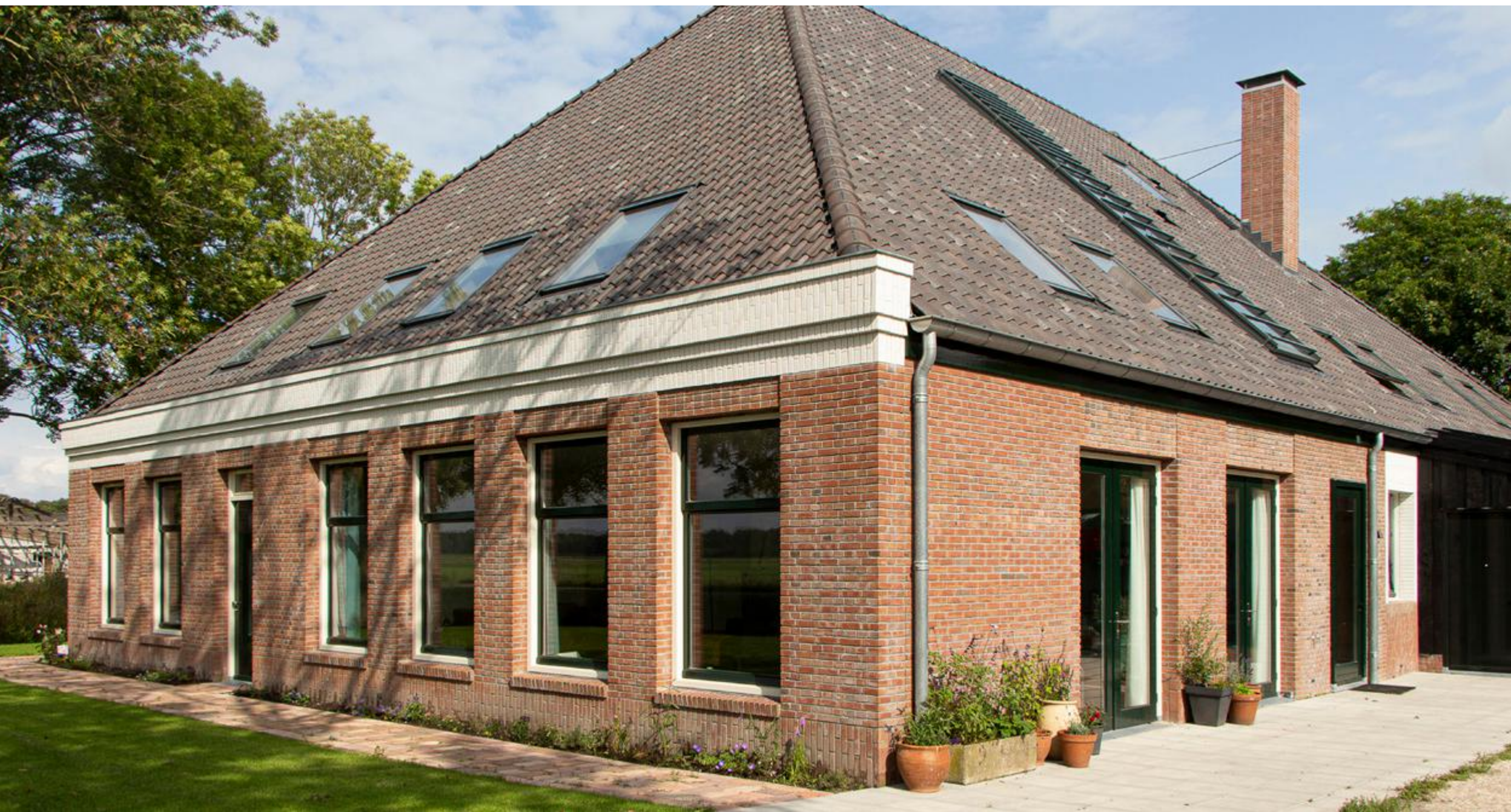
Nieuwbouw stolpboerderij Weltevreden - Purmer
