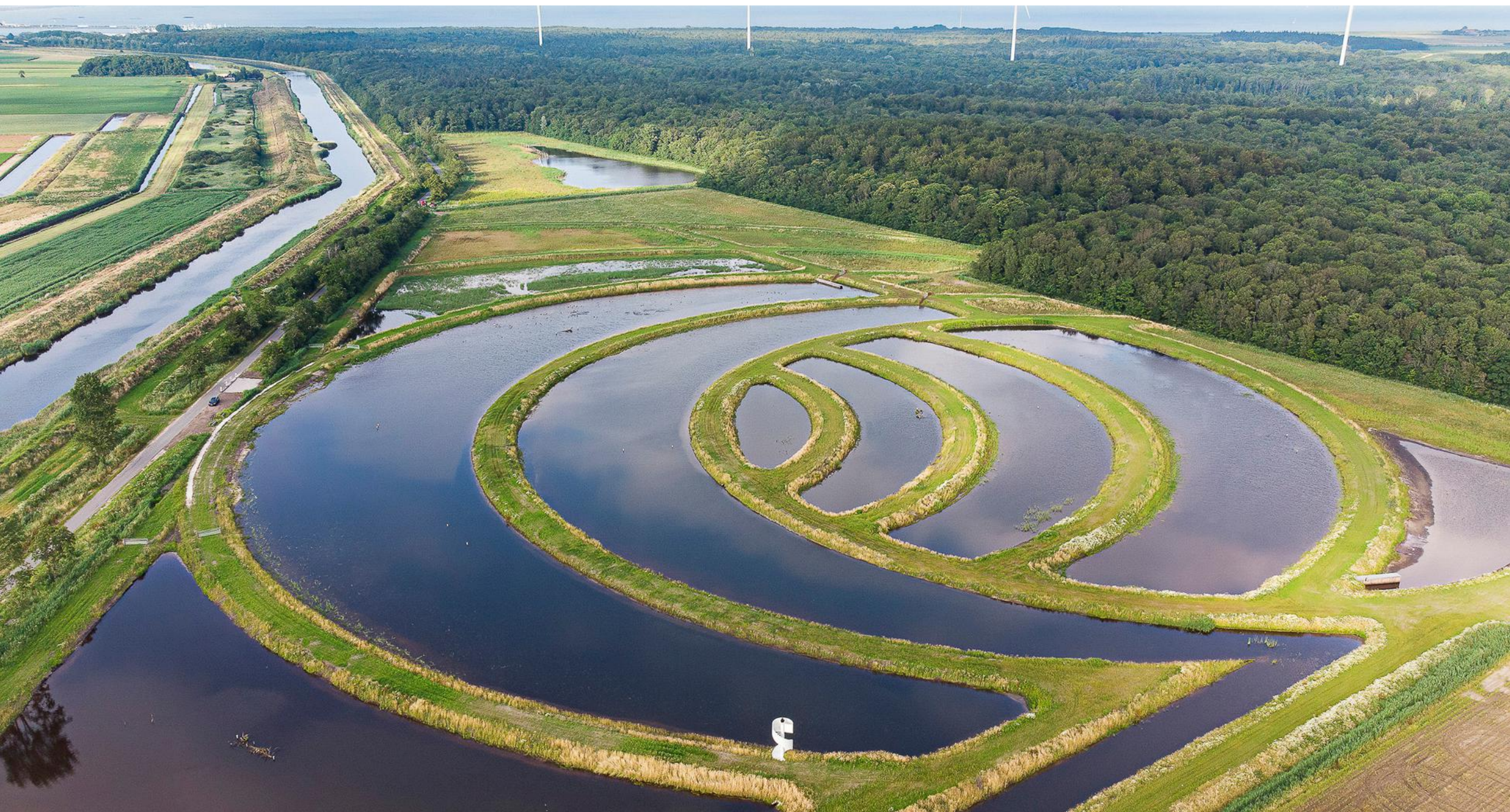
Wieringermeer VisKringloop - Wieringermeer
