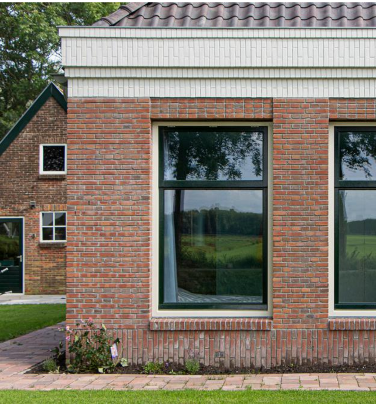
Nieuwbouw stolpboerderij Weltevreden - Purmer
